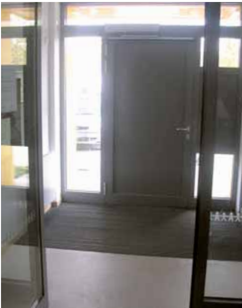
Haupteingang mit Windfang und Schuhabstreifmatte
