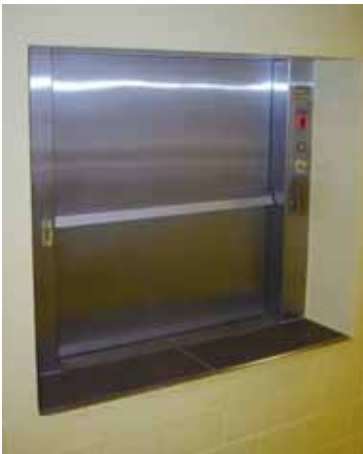
Durch Schlüsselschalter gesicherter Speisenaufzug
