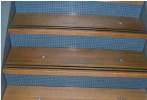
Gut erkennbare Treppe mit Setzstufen
