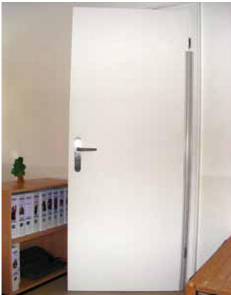
Tür mit Absicherung der Nebenschließkante
