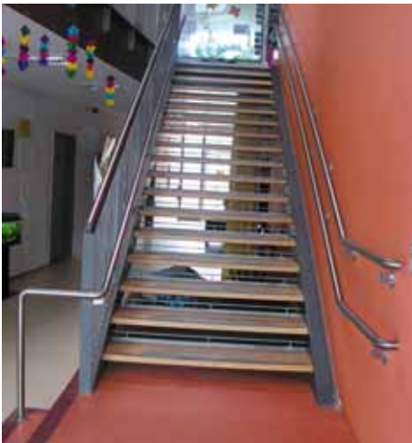
Treppe mit Handläufen und Sicherung der Setzstufen
