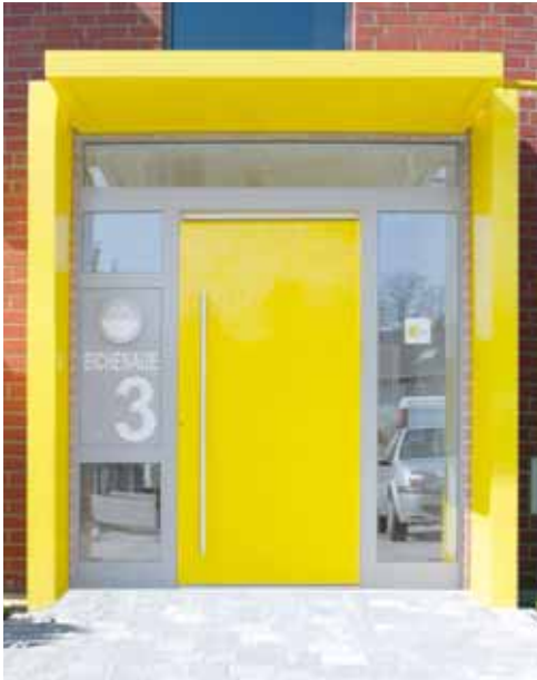
Barrierefreier Eingang mit automatisch öffnender Tür
