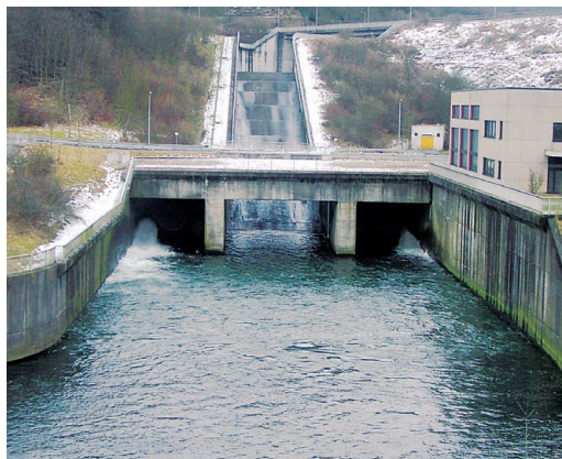
Abb. 4.2-1 Staudamm der Wuppertalsperre [Foto: M. Knippenberg]
