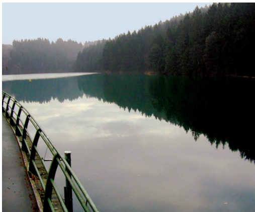
Abb. 2.1.3.3-5 Sengbach. Beispiel für die erhebliche Veränderung eines Fließgewässers durch Talsperrenbetrieb (Strukturgüteklasse 7: vollständig verändert)
