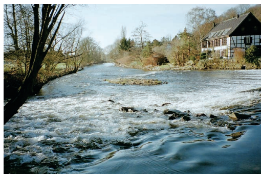
Abb. 2.1.3.3-3 Wupper am Wipper- kotten bei Solingen (Flusskilometer 16). Historischer Schlei- f- kotten mit altem Wehr (rechts) und neu angelegter rauer Rampe als Fischeuf- stiegsanlage. Beispiel für Strukturgüteklasse 5 (stark verändert)
