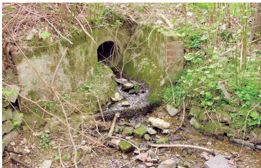
Abb. 3.1.5-3 Verrohrung im Stei- nendorfer Bach (Nebengewässer des Nacker Baches) (Quelle: Planungsbüro Koenzen)
