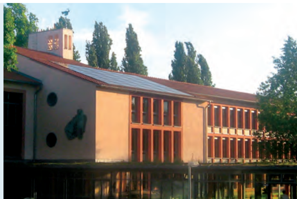
Photovoltaik-Anlage auf dem Schulgebäude Schorlemerstraße 99
