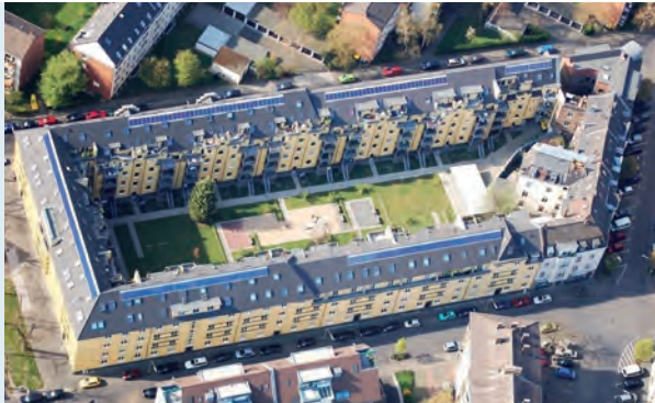
Solarsiedlung Riehl nach der Sanierung
