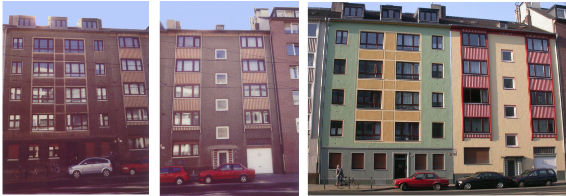
Abbildung 8 Fassadenneugestaltung Kölner Straße ( vorher und nachher)
