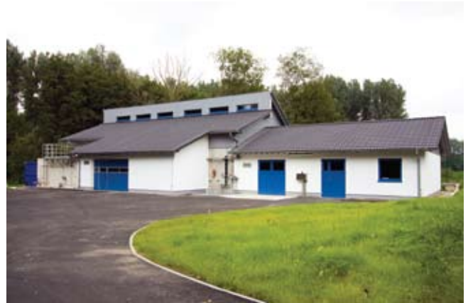
Neubau Klärwerk Schöller
