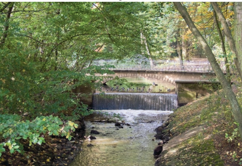
Wehr an der Bastau vor Mündung in die Weser
