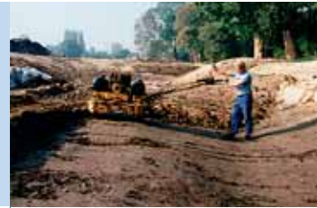
Arbeiten am Moersbach. In den fünfziger Jahren und heute.
