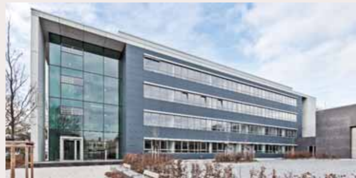
Allgemeines Verfügungszentrum (AVZ) für die RWTH Aachen, 1. Bauabschnitt
