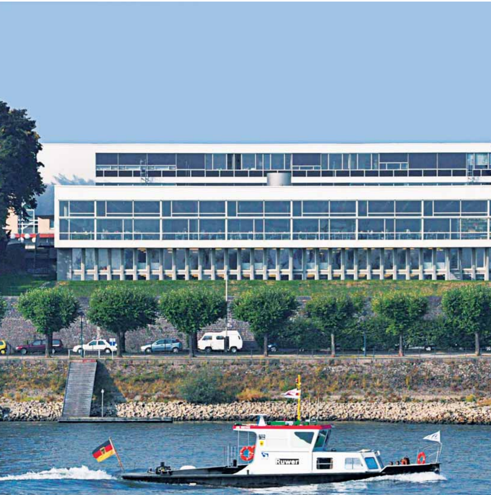
Fassade zur Rheinseite
