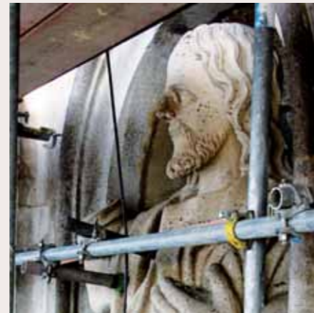
Namen-Jesu-Kirche in Bonn mit Baugerüst
