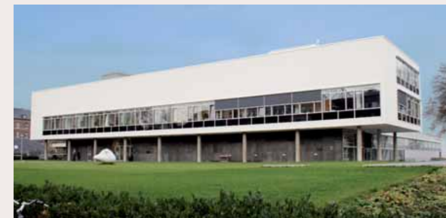
Fassade zur Adenauer Allee
