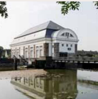
Die denkmalgeschützte Wasser- verteilungsanlage in Hamm
