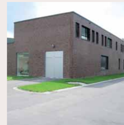
Theodor-Blank-Kaserne Rheine-Bentlage: Gebäude für Rettungs- und Sicherheitsgerät
