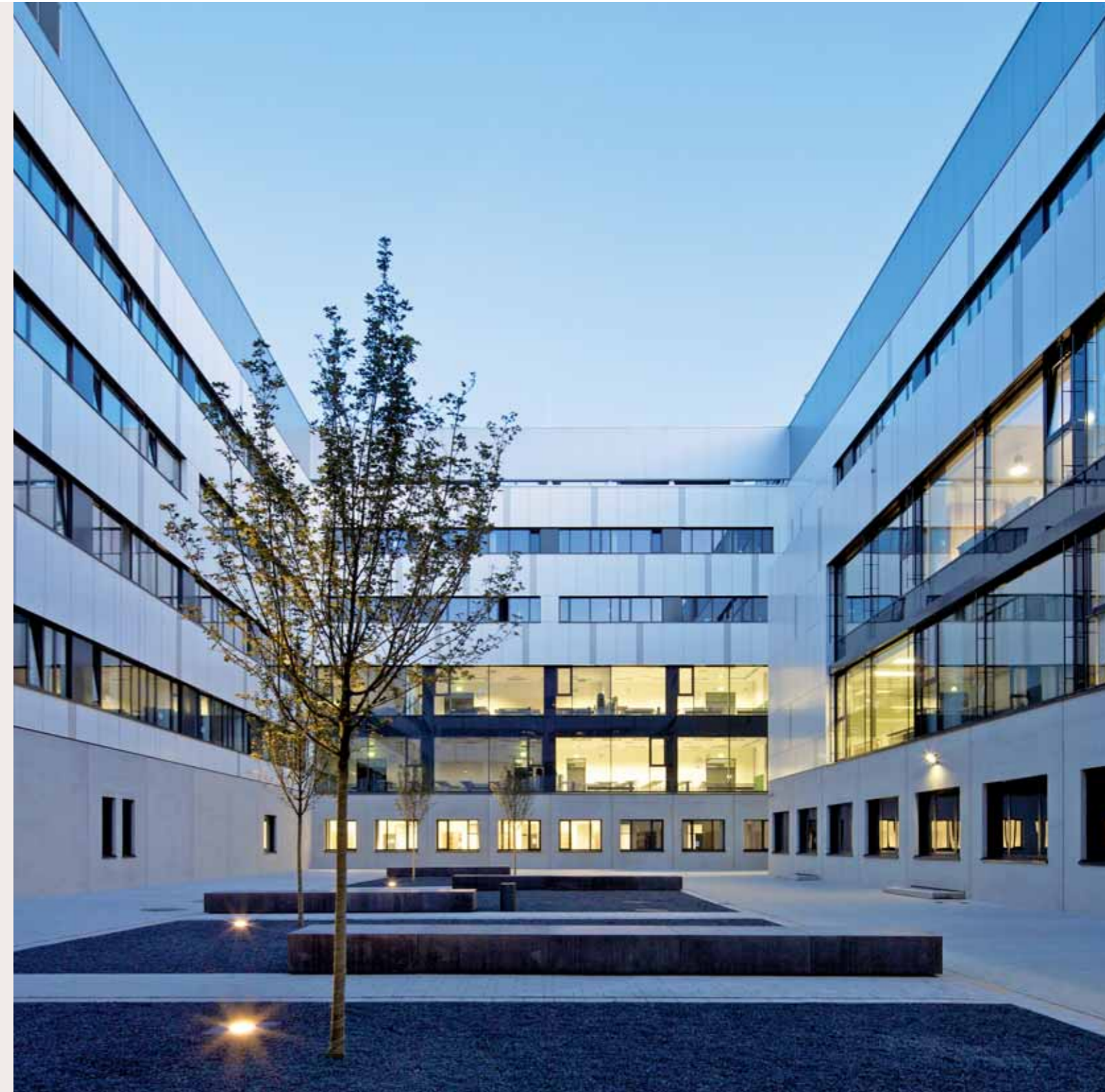
Der Innenhof des ID-Gebäudes
