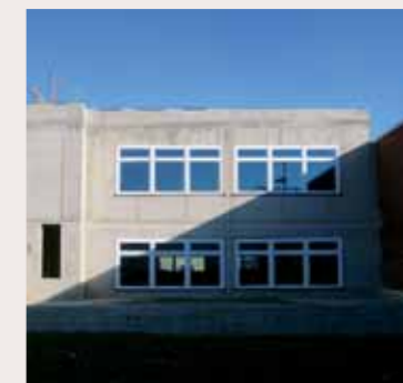
Justizvollzugsanstalt Rheinbach: Werkhalle
