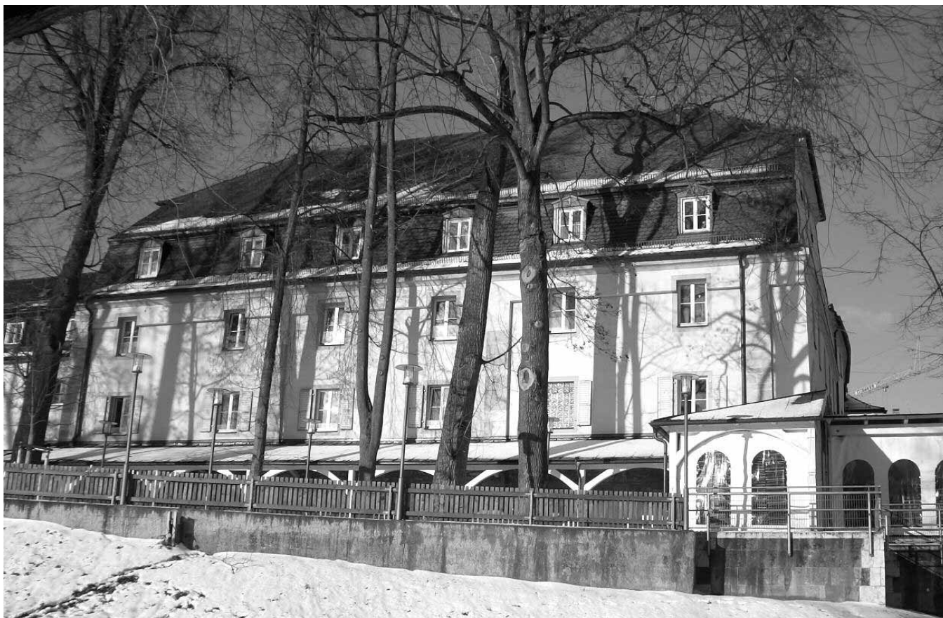
Abb. 1: Ehemaliges Infirmiergebäude mit Spitalarchiv, 13. Jhd
