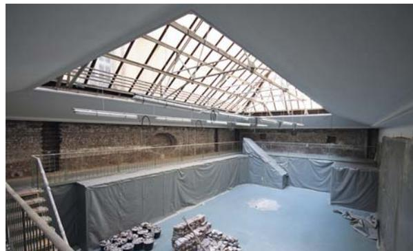
Die Sanierung des Stahl-/Glas-Walmdaches oberhalb der Bibliothek wird in Kürze abgeschlossen.
