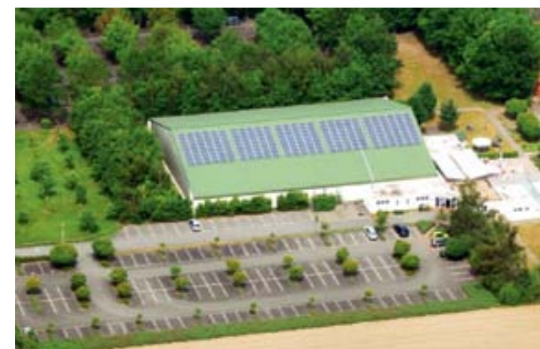
Luftaufnahme: Tennishalle mit Solardach (Photovoltaikanlage)
