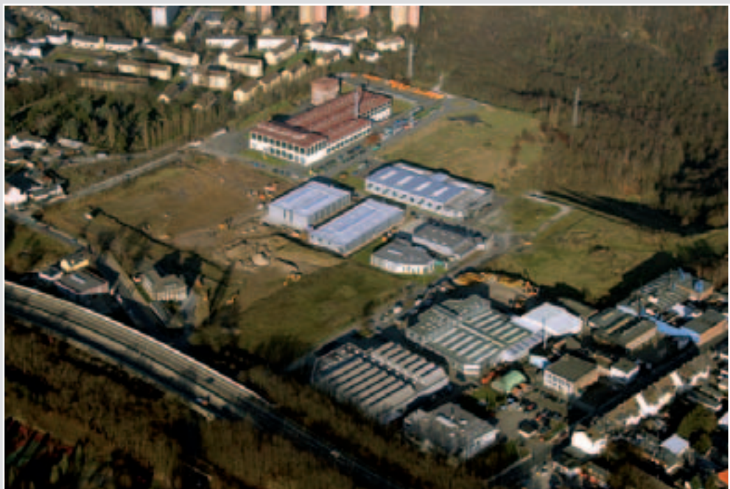
Luftbild Gewerbegebiet Talstraße
