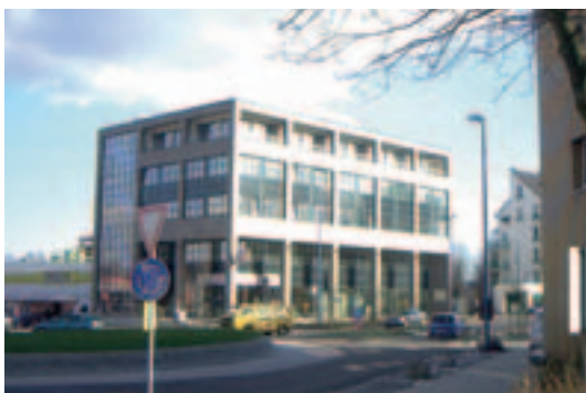
Büro- und Geschäftshaus am City-Park
