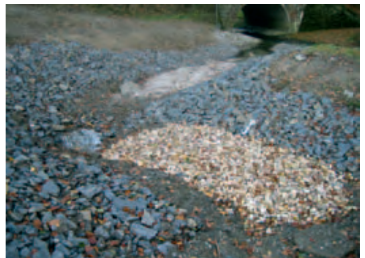
Bild 16.4: Mittelkies (links) und Grobkies (rechts) als Laichsubstrat Fig. 16.4: Medium gravel (left) and coarse gravel (right) used as spawn substrate
