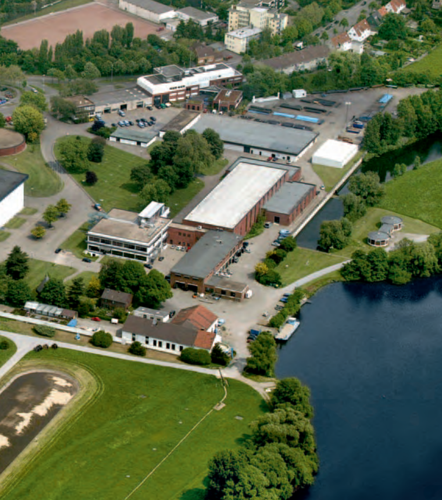
RWW-Wasserwerk Mülheim-Styrum (Ruhr)
