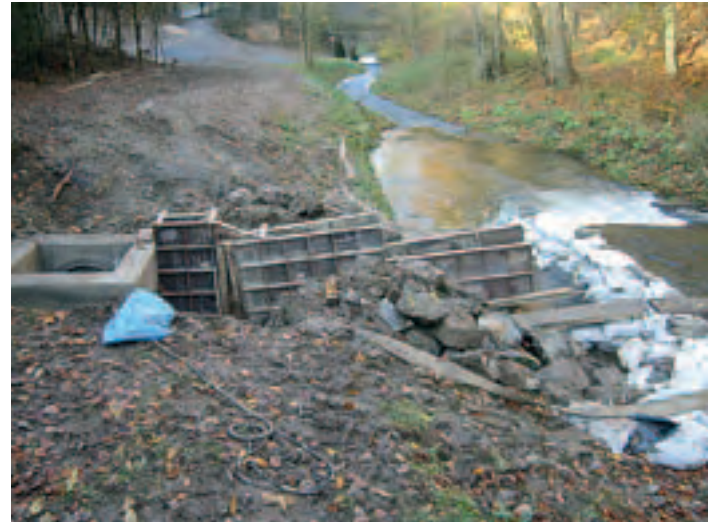
Bild 16.3: Einlassbauwerk im Bau Fig. 16.3: Intake building under construction
