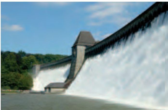
Bild 15.6: Überlauf der Möhnetalsperre mit 64 m 3 /s am 11. August 2007 Fig. 15.6: Overflow of the Moehne reservoir with 64 m 3 /s on August 11, 2007
