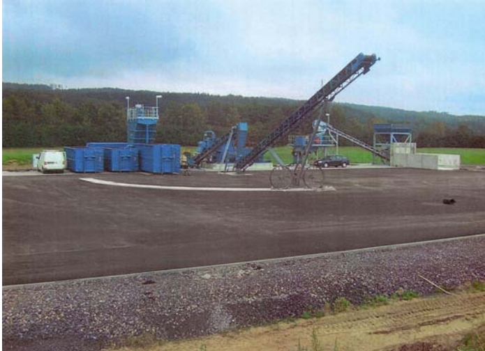
Bild 16.5: Anlagenfertigstellung Fig. 16.5: Completing the facility
