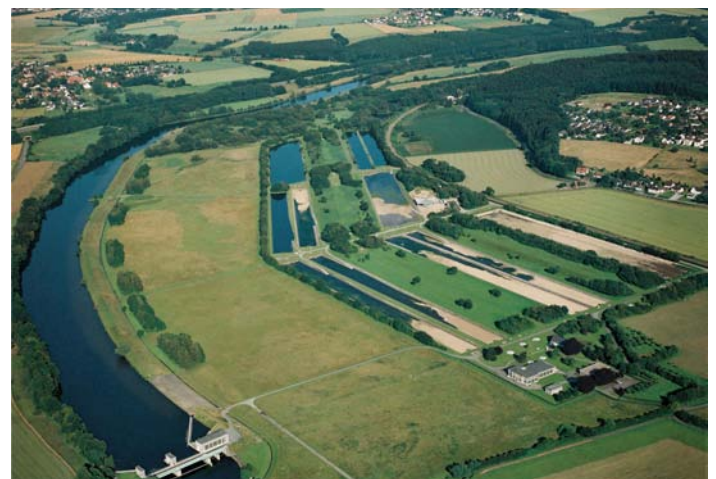
Bild 15.1: Wassergewinnungsanlage im Ruhrtal im Bereich Wickede-Echthausen
