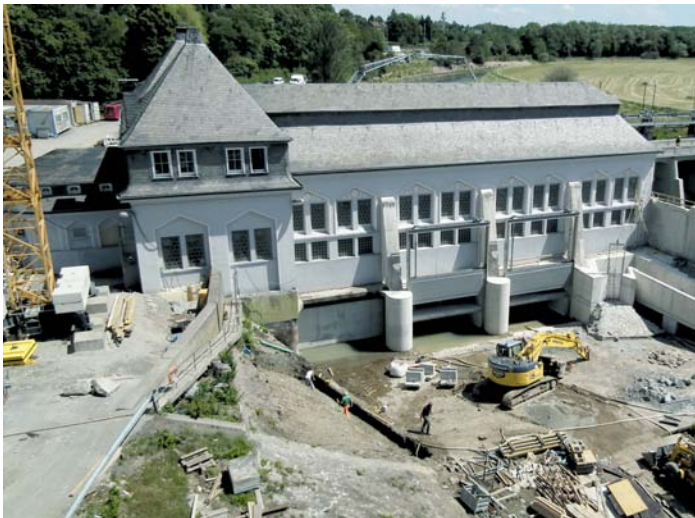
Bild 14.1: Denkmalgeschütztes Krafthaus von der Unterwasserseite Fig. 14.1: Listed power house from the downstream side
