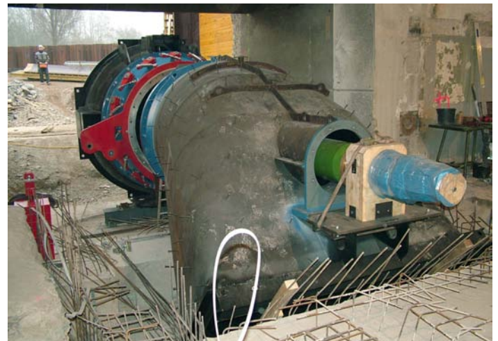
Bild 14.4: Saugrohrkrümmer mit Leitapparat während der Montage Fig. 14.4: Draft tube elbow and guide vanes during assembly
