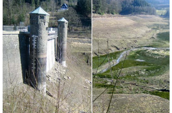
Bild 4.4: Abgestaute Fürwiggetalsperre im Frühjahr 2007 Fig. 4.4: Emptied Fürwigge Reservoir in spring 2007
