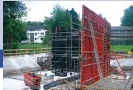
Neubau KW Schöller
