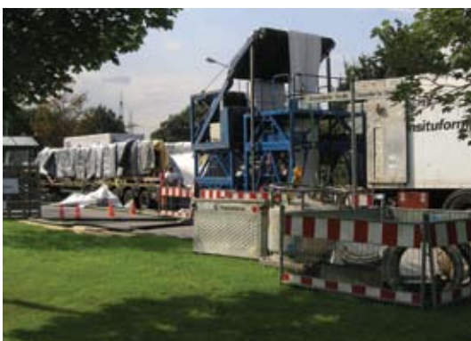
Baustelleneinrichtung für Schlauchrelining-Verfahren
