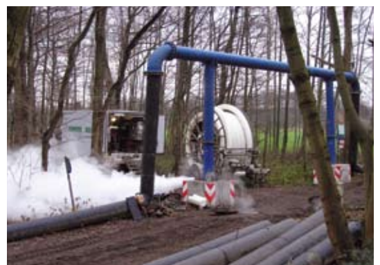
Inlinerverfahren-Verfahren am Überleitungskanal Haan-Hilden
