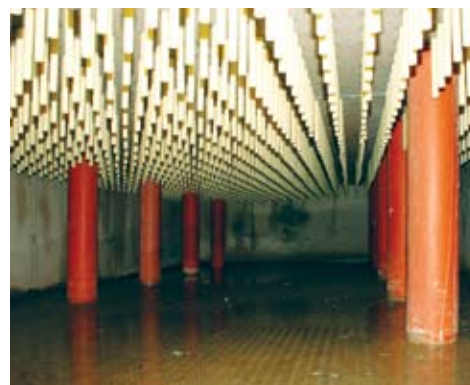
Ansicht des Filterbodens Denitrifikationsreaktor KW Hochdahl
