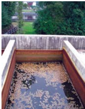
Denitrifikationsreaktor KW Hochdahl
