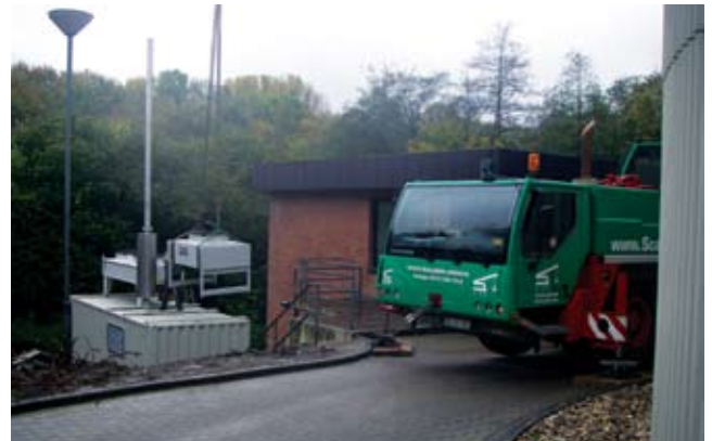
Aufstellung eines BHKW-Containers auf dem KW Mettmann
