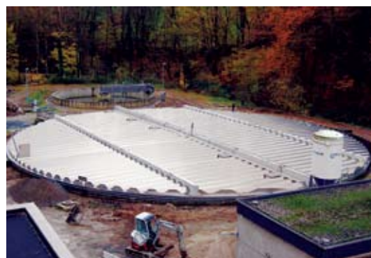
Montage Abdeckung Klärwerk Gräfrath
