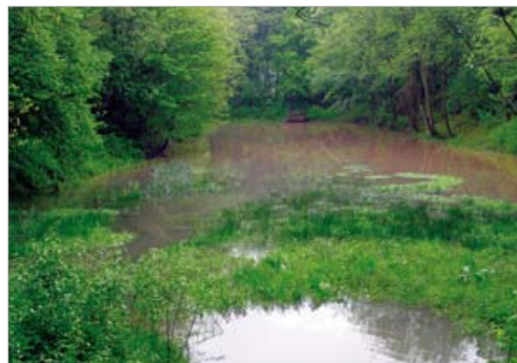
Hochwasserrückhaltebecken Wiesenbach in Neviges
