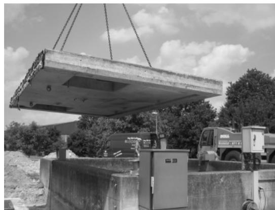
*Abheben der Betondecken zur Freilegung der Rohrleitungen*
