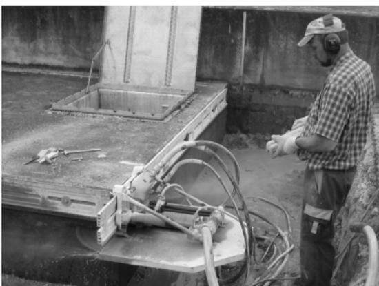
*Betonschneidearbeiten zum Abtrennen der Schachtbetondecken*
