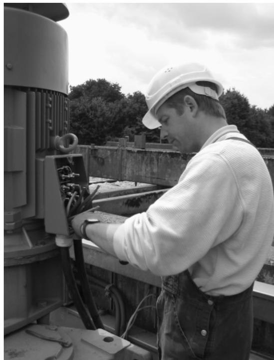
**KW Goch - Ludger Metzelaers beim elektrischen Anschluss der neuen Belüftereinheit**
