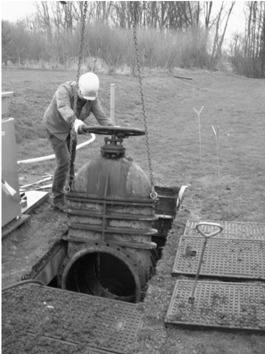
Erion Düring beim Ausbau des Zulaufschiebers der Rohrleitung aus Kempen auf dem KW Grefrath
