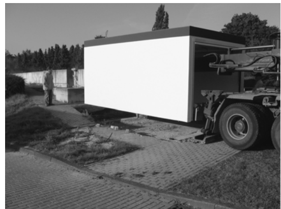
Aufstellung der Fertiggebäude für die Neutralisationsanlage (li.) und für die Polymerzugabestation (re.)
