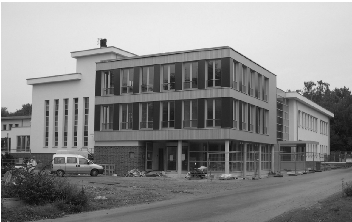
Klärwerk Mönchengladbach-Neuwerk – Fertigstellung der Hochbauarbeiten am Betriebsgebäude
