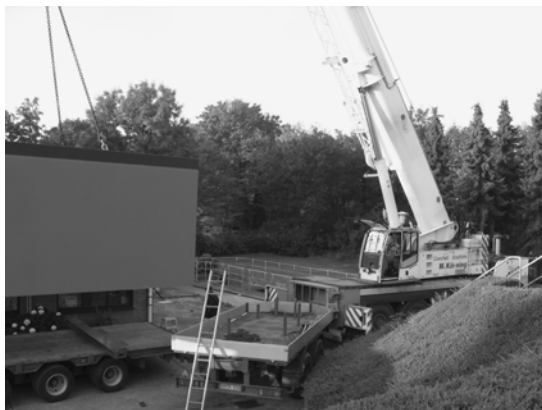
Aufstellung der Fertiggebäude für die Neutralisationsanlage (li.) und für die Polymerzugabestation (re.)
