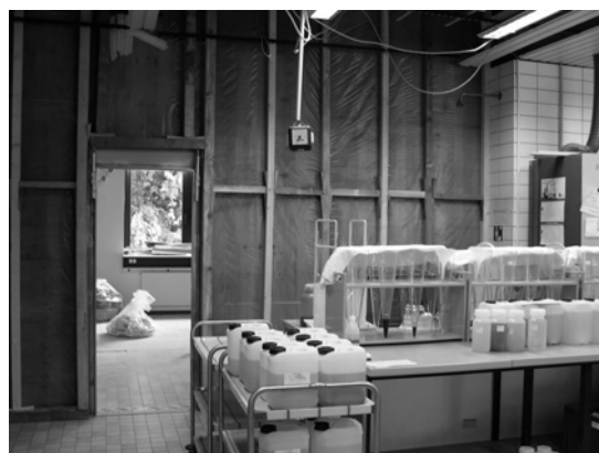
Staubschutzwand zum Schutz der analytischen Bereiche während der Umbauarbeiten
