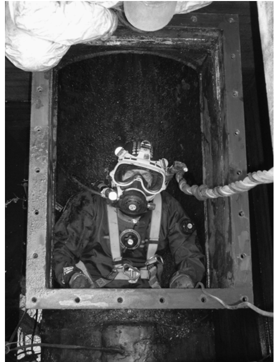
Taucher vor dem Ausbau der Korrosionsschutteinrichtungen in der Abwasserleitung Kempen - Grefrath
