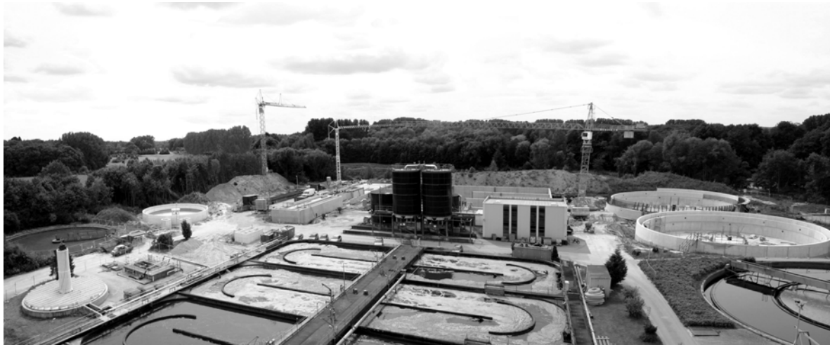
Klärwerk Geldern – Überblick über die Gesamtanlage mit weitgehender Fertigstellung der Rohbauarbeiten
