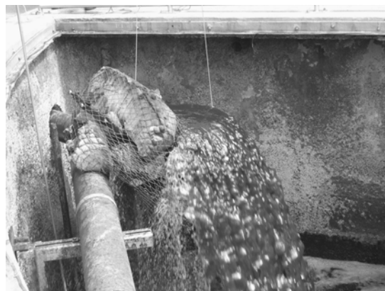
„Reinigungsmolch“ vor dem Einsatz und nach der Reinigung am Rohrleitungsende auf dem KW Grefrath
