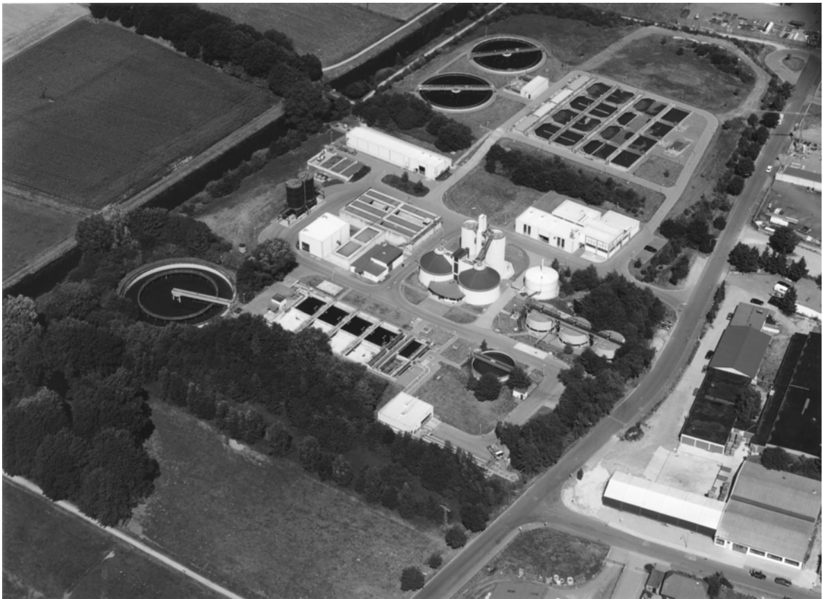
Das Klärwerk Goch im nördlichen Bereich des Einzugsgebietes
