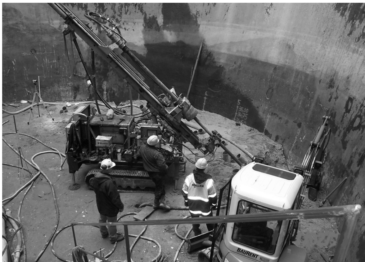
Klärwerk Mönchengladbach-Neuwerk – Stabilisierung des Baugrundes unter der Behältersohle
