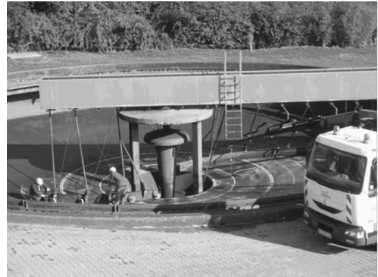
Inspektion einer Nachklärung auf der Kläranlage Kavelaer – Weeze
