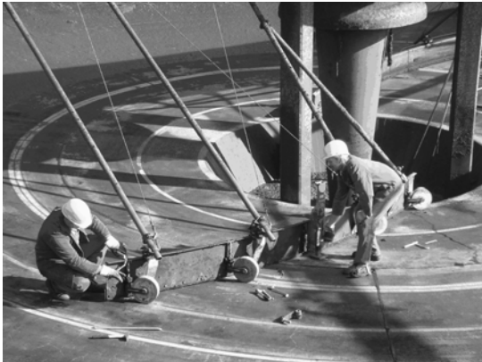
Inspektion einer Nachklärung auf der Kläranlage Kavelaer – Weeze
