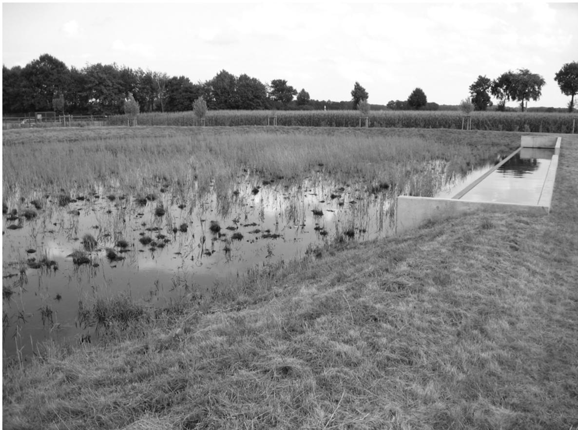
**NWBA Höhenhöfe – Einstau des Bodenfilters nach einem Regen**
