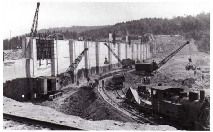
Bau der Versetalsperre 1949
