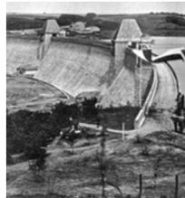
Die leicht bogenförmige Gewichtsstaumauer besteht aus Bruchsteinen. Sie ist 650 m lang und bis zu 40 m hoch und kann 134,5 Millionen m<sup>3</sup> Wasser aufstauen.
