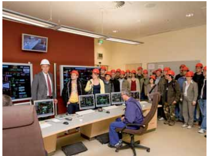
Volker Leonhardt, WSW, erklärt den Exkursionsteilnehmern die Leitwarte des Heizkraftwerks Barmen
