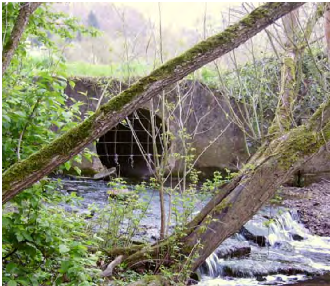
Einleitung in die Dhünn
