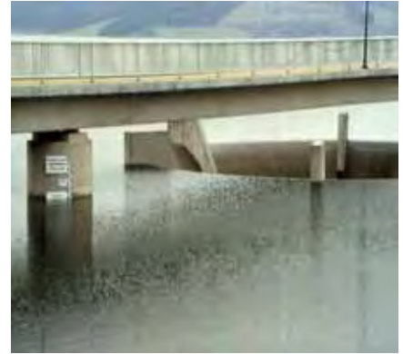
Hochwasserentlastungstrichter der Talsperre
