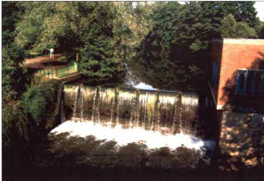
Der Absturz am Auermühlenwehr vor dem Umbau (Foto: Risch 1999)
