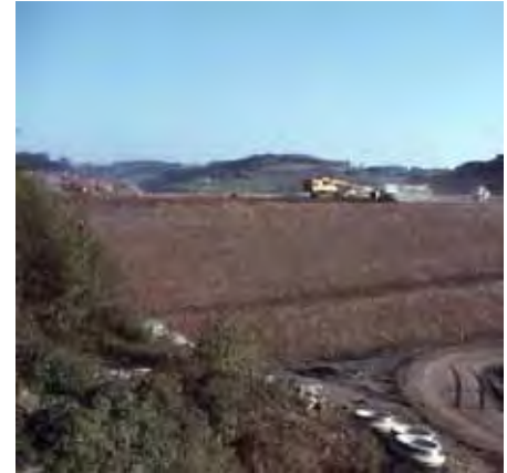
Damm der Großen Dhünn-Talsperre im Bau 1980
