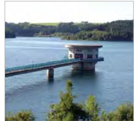
Entnahmeturm der Großen Dhünn-Talsperre
