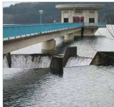
Talsperre bei hohem Wasserstand / Vollstau
