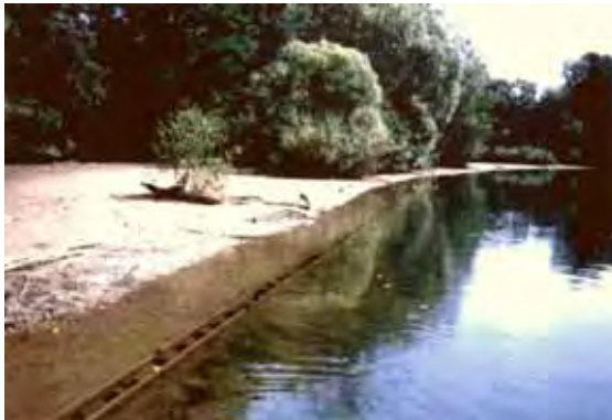
Großer Stauteich hinter dem Wehr (Foto: Mager 1999)
