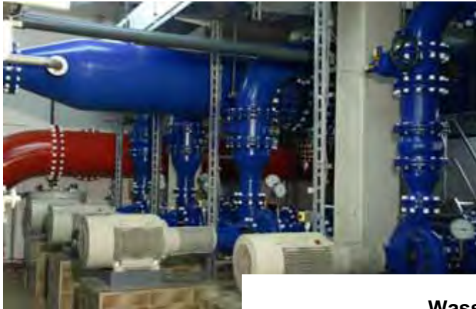
Wasseraufbereitungsanlage des Wasserversorgungsverbandes Rhein-Wupper WVV Leitstand der Trinkwasseraufbereitungsanlage Wasserwerk Schürholz, Zwischenpumpwerk (Förderleistung max. 2000 m 3 /h) und Filterstufe 3 (Entsäuerung mit Jurakalk); Fotos mit freundlicher Genehmigung des WVV
