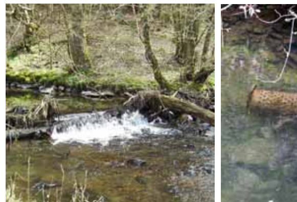
Absturz "Markusmühle" am Eifgenbach und Wasserentnahmeleitung
