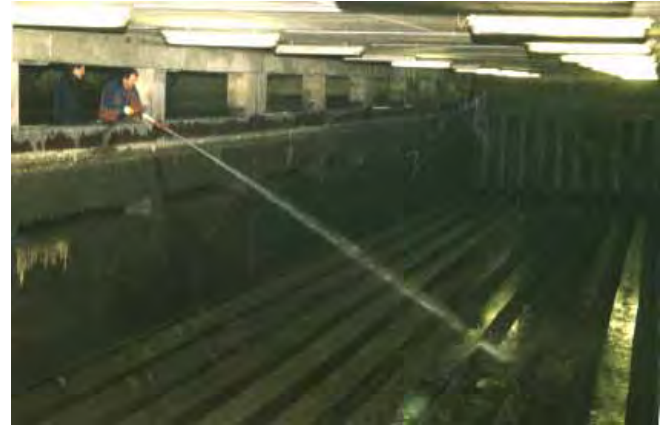
Säuberung eines unterirdischen Regenrückhaltebeckens RÜB
