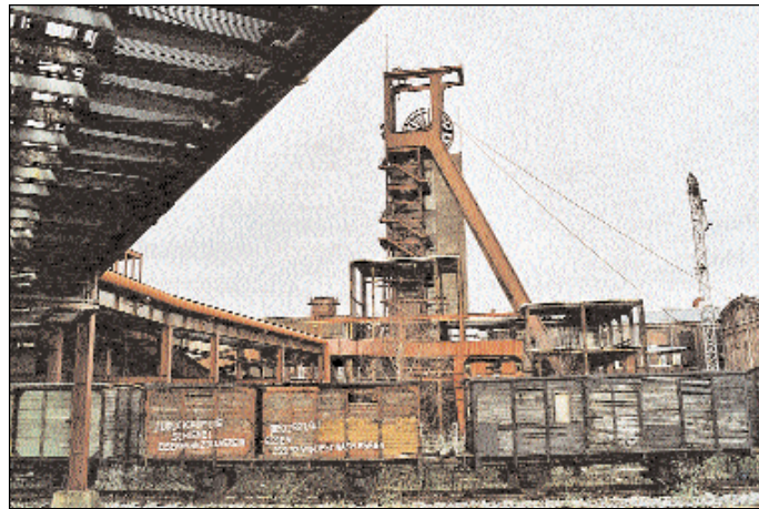
Schachtgerüste der Schächte 1 (vorne) und 2 (im Hintergrund).
