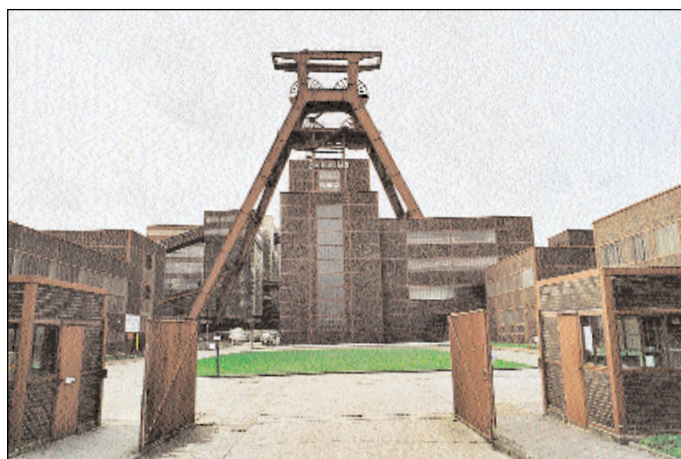
Tagesanlage von Schacht 12 mit dem 56 Meter hohen Doppelbockfördergerüst.
