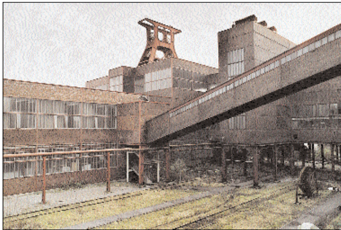
Direkt dem Förderturm angeschlossen, die Anlagen für Kohlenverarbeitung und -transport.
