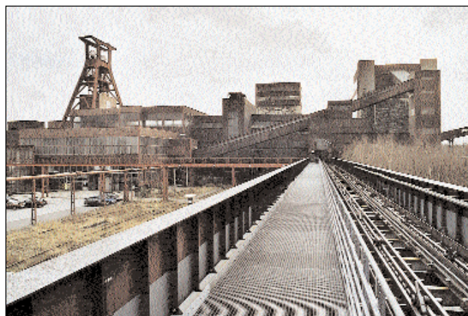
Die Transportbrücke zwischen Schacht 12 und Schacht 1/2.
