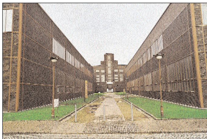
Die Mauern von Kesselhaus und Kompressor bergen heute das Design-Zentrum NRW und das Casino Zollverein.
