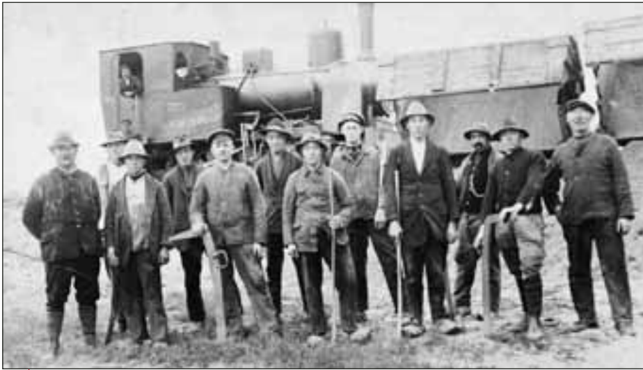
Eine Arbeitskolonne beim Bau im Jahre 1925.
