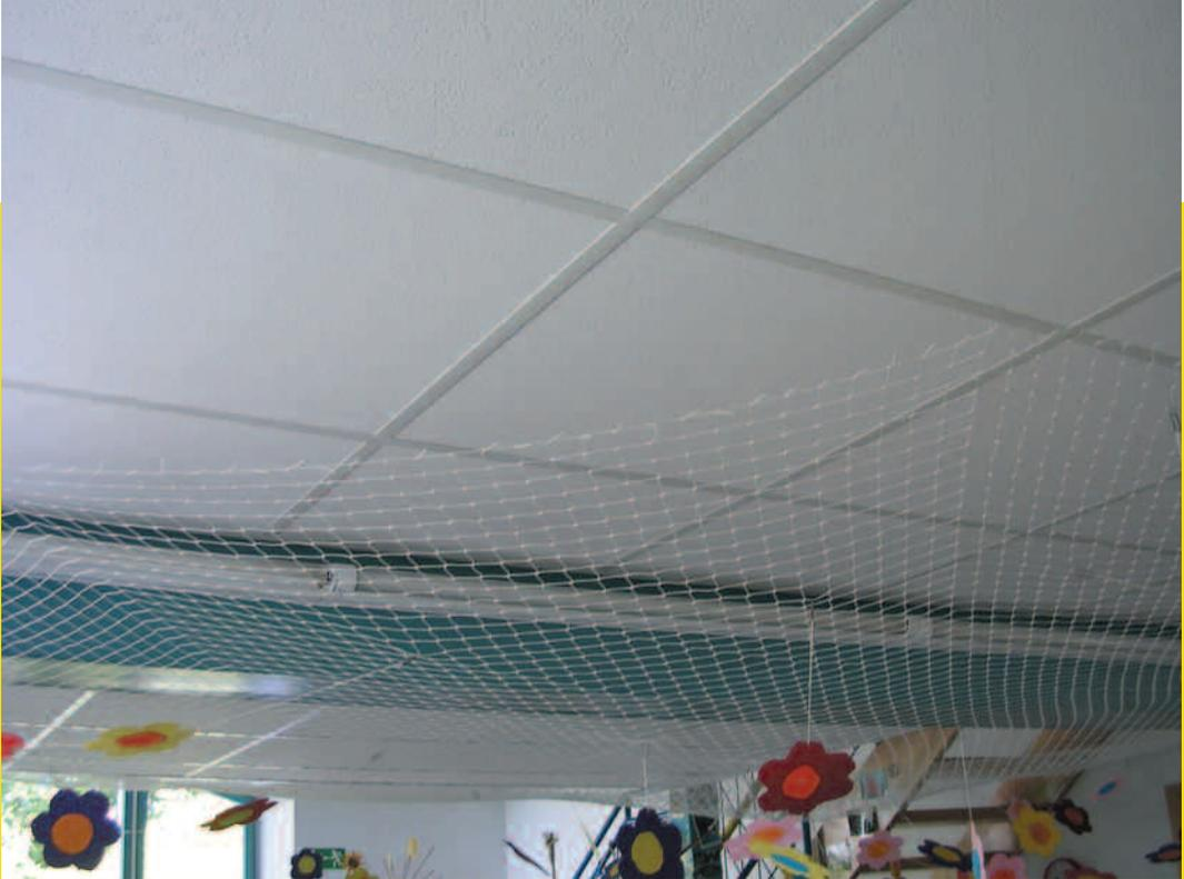
Schallabsorbierende Decke mit abgehängten Akustikplatten
