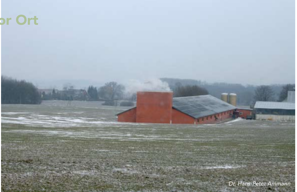
Mastbetrieb im Münsterland
