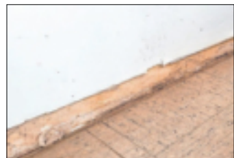
Auch am Erasmus-Gymnasium zeigen die Frontplatten überdeutliche Anzeichen ihrer Vergänglichkeit (oben). Die Fußleisten sind ebenfalls verletzungsgefährlich angefrassen (links) Kleines Bild: Klaus Krützens und Arno Jansen.
