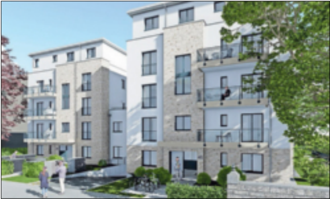
Beim derzeit laufenden „Pick“-Neubau an der Lindenstraße wird auch den Erhalt der alten Bäume geachtet. Und neue sollen hinzukommen.
