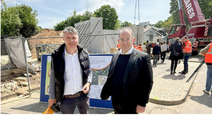
Lars Becker mit Jörg Geerlings bei der Besichtigung der Baustelle.
