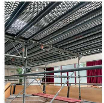
In den Sommerferien wurde die Decke des Pädagogischen Zentrums neu gestrichen.
