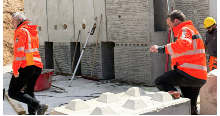
Die drei Brücken konnten dank des „Baukastenprinzips“ mit mehreren Fertigteilen besonders schnell errichtet werden.
