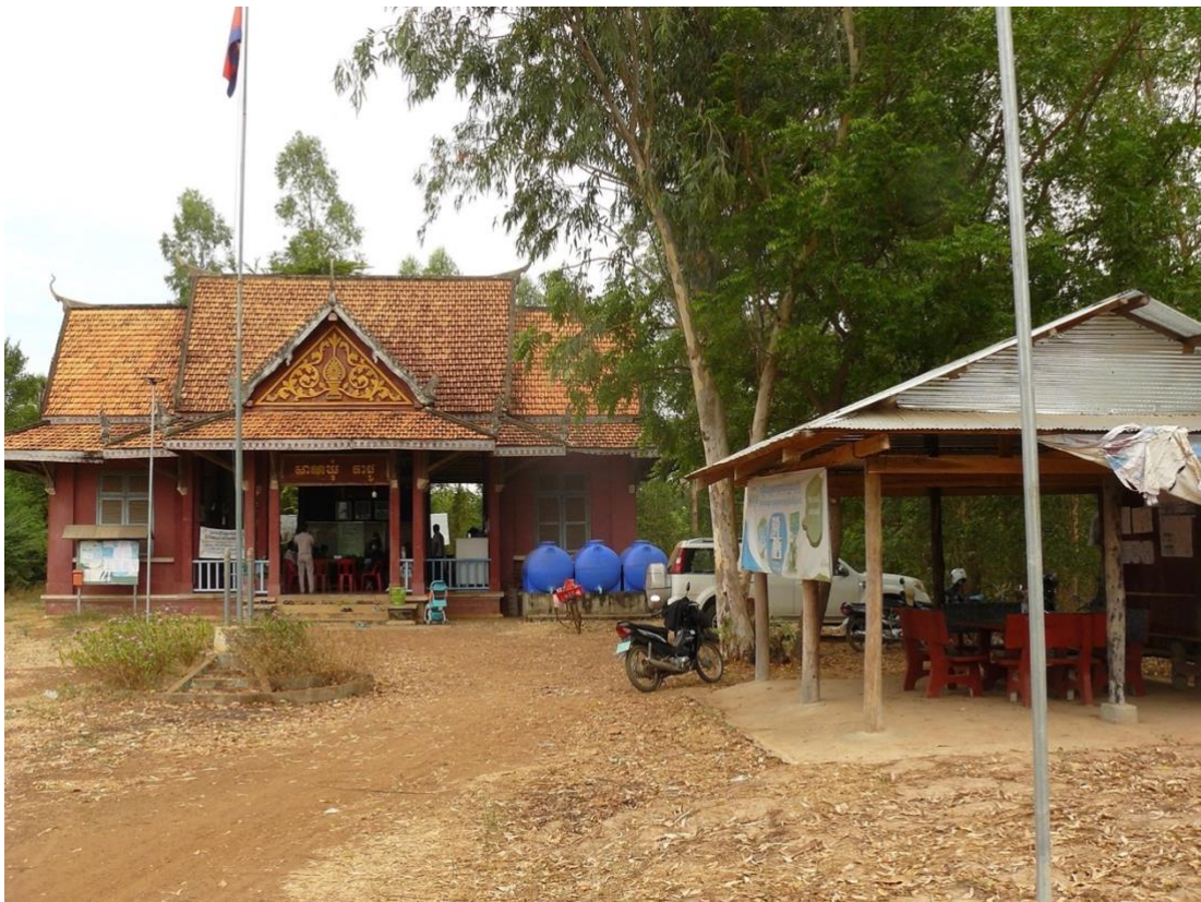
Abb. 5: Typisches commune -Verwaltungsgebäude, wie sie im Rahmen eines ADB-Programms in allen sechs Provinzen errichtet wurden.
