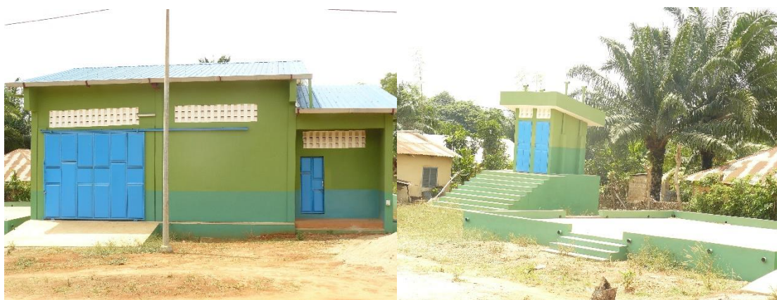
Abb. 3 und 4: Lagerhaus mit dazugehörigem Trocknungsplatz und Toilette
