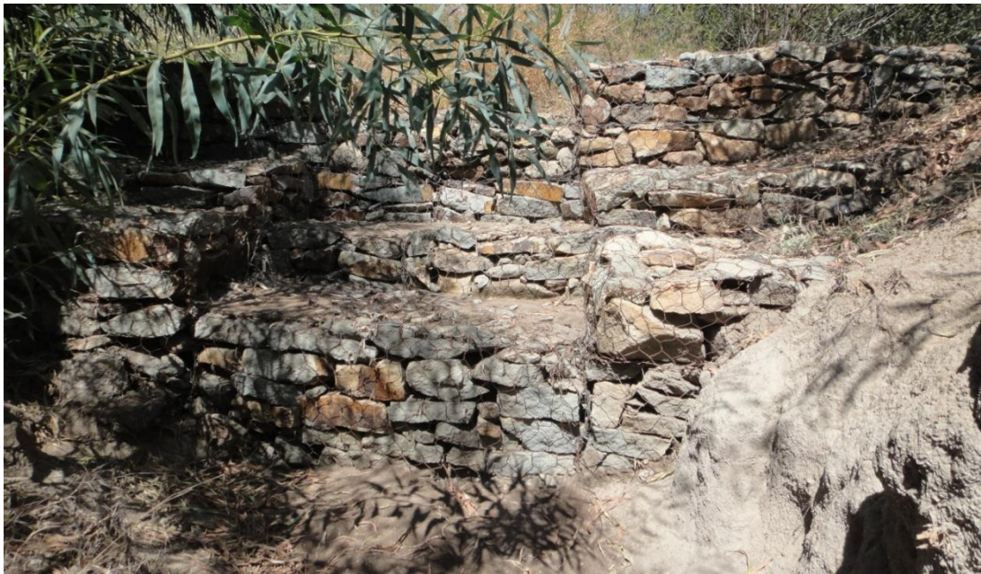
Abb. 5: Verbau eines Gullies mit Hilfe von Gabionen
