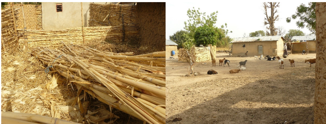
Abb. 10 und 11: Mit Sorghumstängeln gebauter und abgedeckter Speicher im Hof einer Familie
