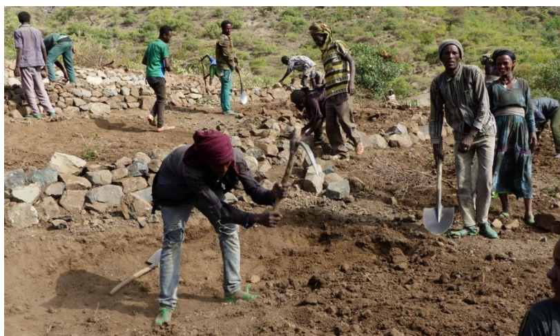
Abb. 4: Terrassierungsarbeiten im Rahmen der public works -Komponente des PSNP in Tigray
