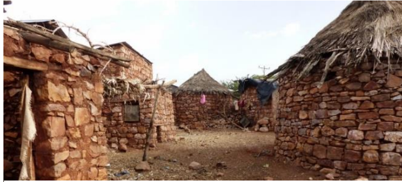
Abb. 1: Sehr armes Dorf in Amhara, die Gebäude sind aus Naturstein mit Lehm gemauert und mit Hirsestroh gedeckt. Es gibt weder eine verbesserte Wasserstelle noch Strom. Rund 2 Stunden Fahrtdauer zur nächsten festen Straße.
