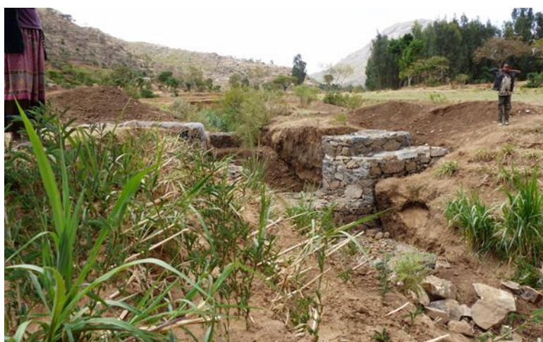
Abb. 6: Beginnend am Oberlauf wird die Ravine derzeit durch den Einsatz von public works verbaut.
