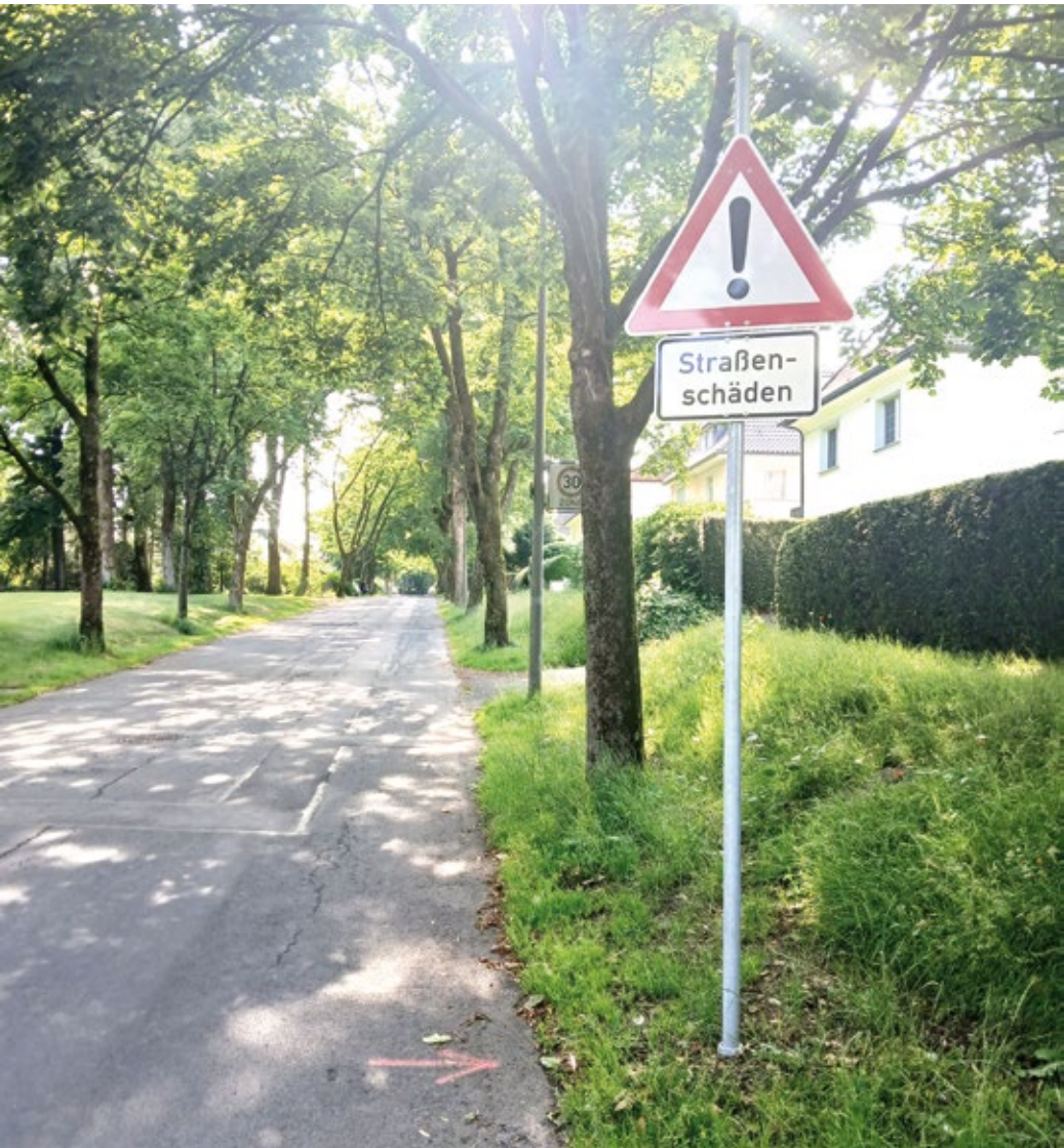
So wie hier an der Albert-Schmidt-Allee in Lennep warnen jetzt Hinweisschilder vor Gefahren durch schadhafte Straßenbelag.
