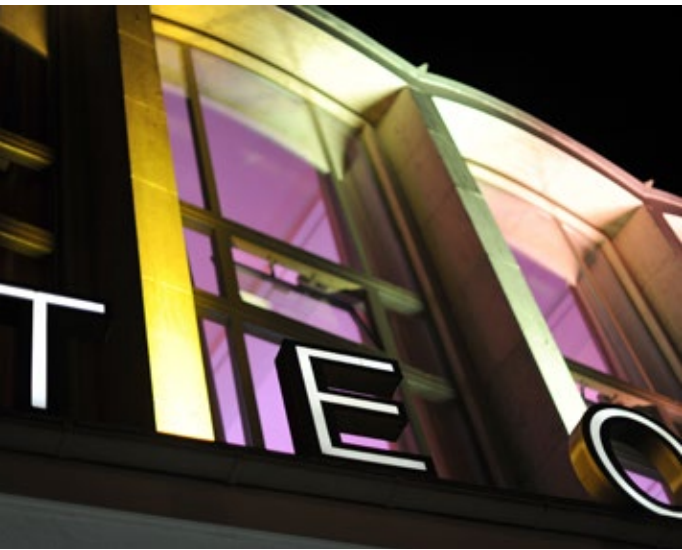
Im Teo Otto Theater stehen Instandsetzungsarbeiten an. Dem Programm in der neuen Saison tut dies aber nur wenig Abbruch.
