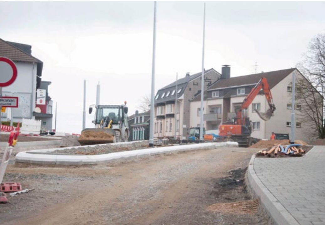
Der Baufortschritt ist von Woche zu Woche sichtbar.
