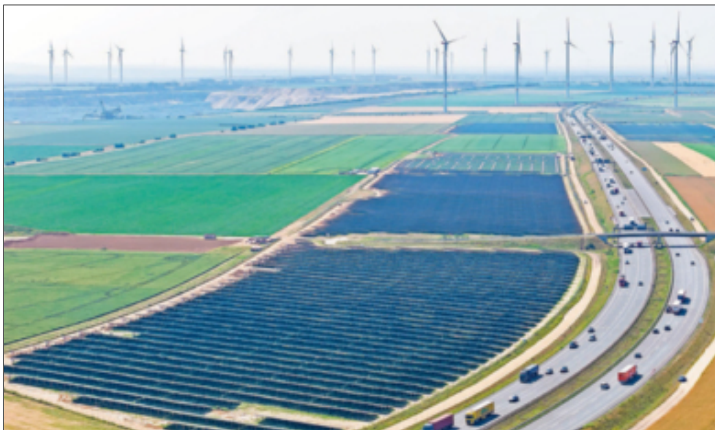
Entlang der Autobahn 44n zwischen Bedburg und Jüchen errichtet RWE derzeit Solaranlagen. Kommandes Jahr soll der Solarpark noch erweitert werden.
