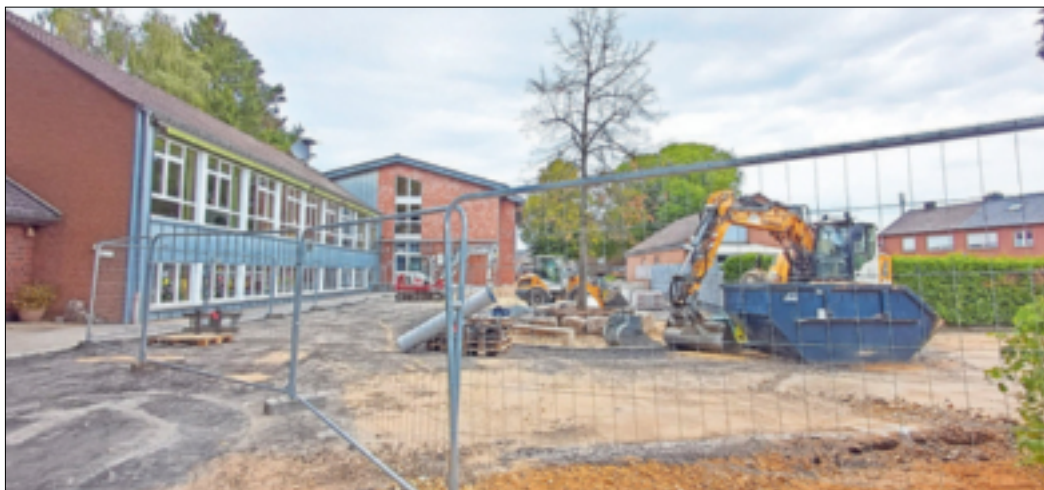
Eigentlich hätte der neue Schulhof zum Schulbeginn fertig sein sollen, doch aufgrund von Verzögerungen waren auch nach den Ferien noch Bauarbeiten im Gange. Fotos: Daniela Furth
