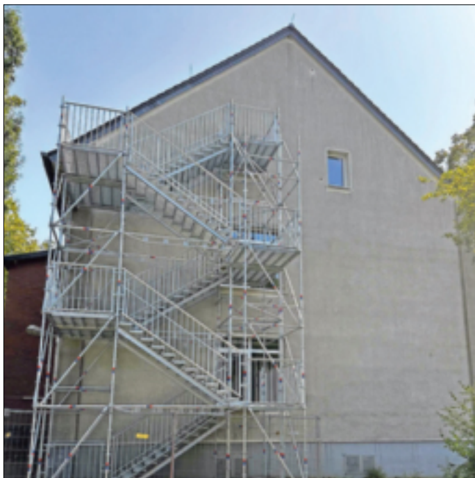
Brandschutztreppen wurden angebaut.
