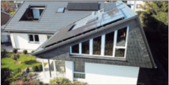
Photovoltaikanlagen auf dem Dach des Eigenheims tragen zu mehr Unabhängigkeit bei der Energieversorgung bei. Foto: djd/ Paul Bauder
