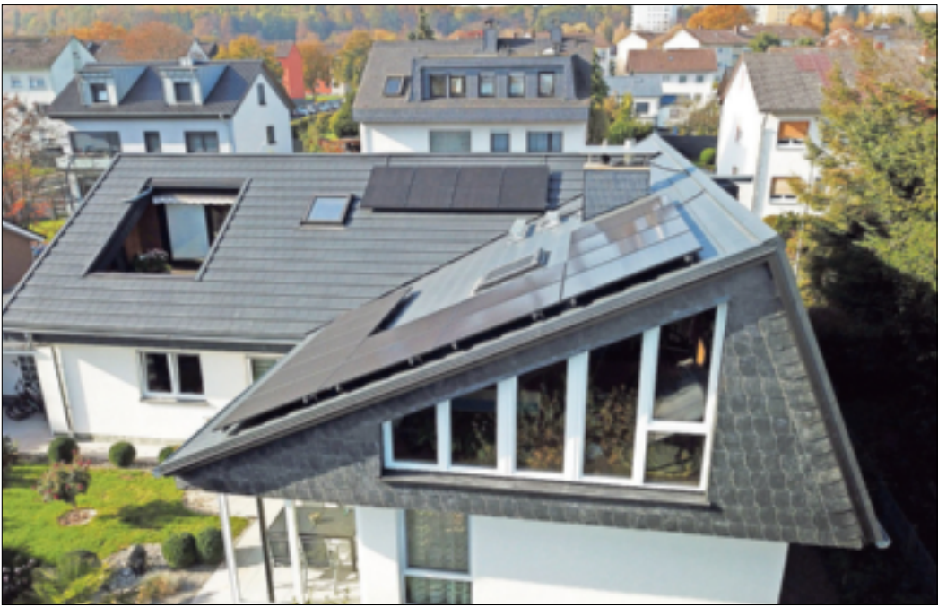
Photovoltaikanlagen auf dem Dach des Eigenheims tragen zu mehr Unabhängigkeit bei der Energieversorgung bei. Foto: djd/ Paul Bauder
