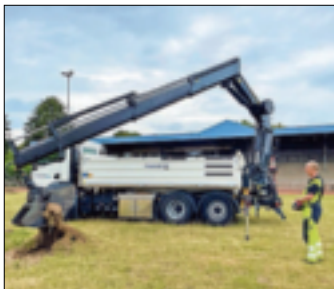
Am Schlossstadion starten die Baugrundvorbereitungen für die Sanierung. Foto: Stadt Grevenbroich
