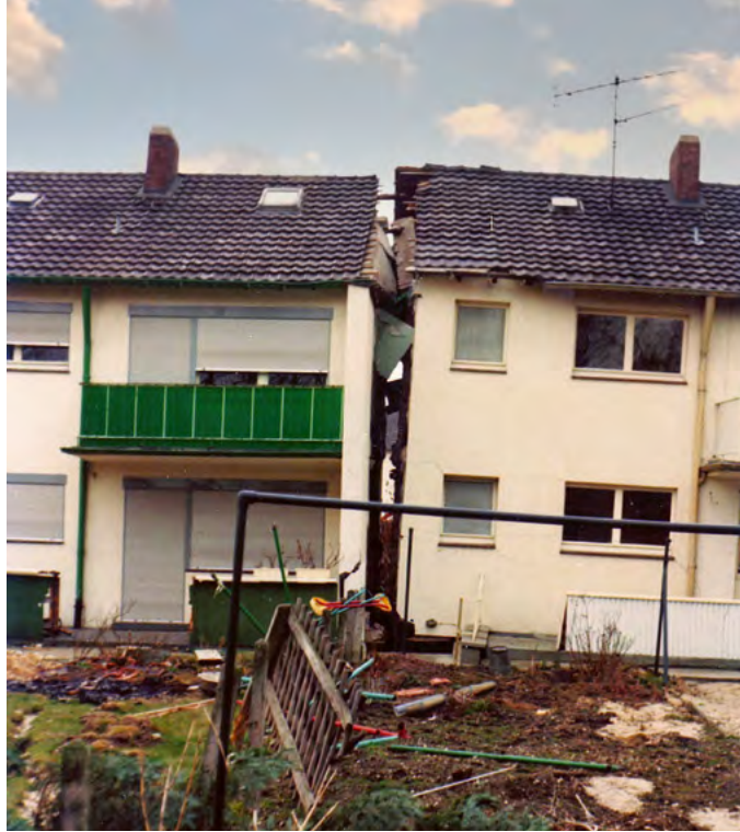
Schäden an Wohngebäuden in Wassenberg nach dem Erdbeben von Roermond 1992
