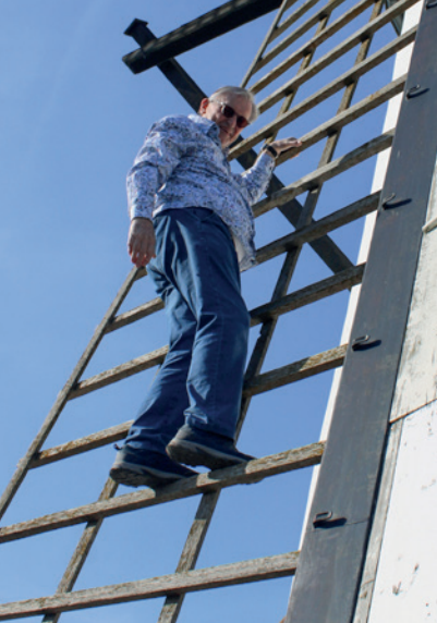
Günter Fritze in luftiger Höhe: Um das Segeltuch zu spannen, müssen die Müller die Latten des Mühlenflügels erklimmen.
