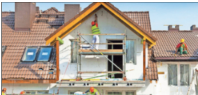
Schluss mit teuren Heizenergieverlusten: Eine Wärmedämmung der Fassade bildet oft den ersten Schritt zu mehr Energieeffizienz. Foto: djd/IVH/PantherMedia/katdom
