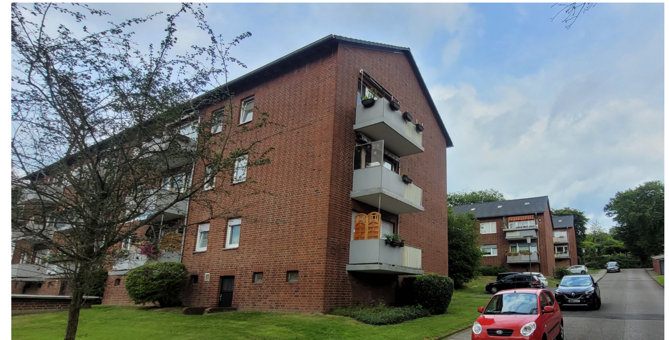
Wohnen im Stadtteil Werden; Foto: Stadt Essen, Amt für Stadterneuerung und Bodenmanagement
