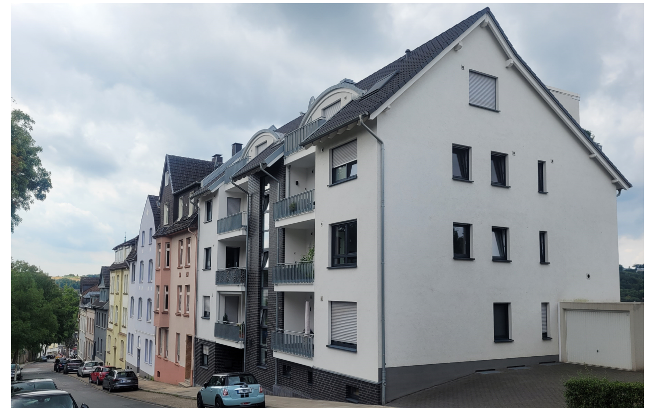
Wohnen im Stadtteil Werden; Foto: Stadt Essen, Amt für Stadterneuerung und Bodenmanagement
