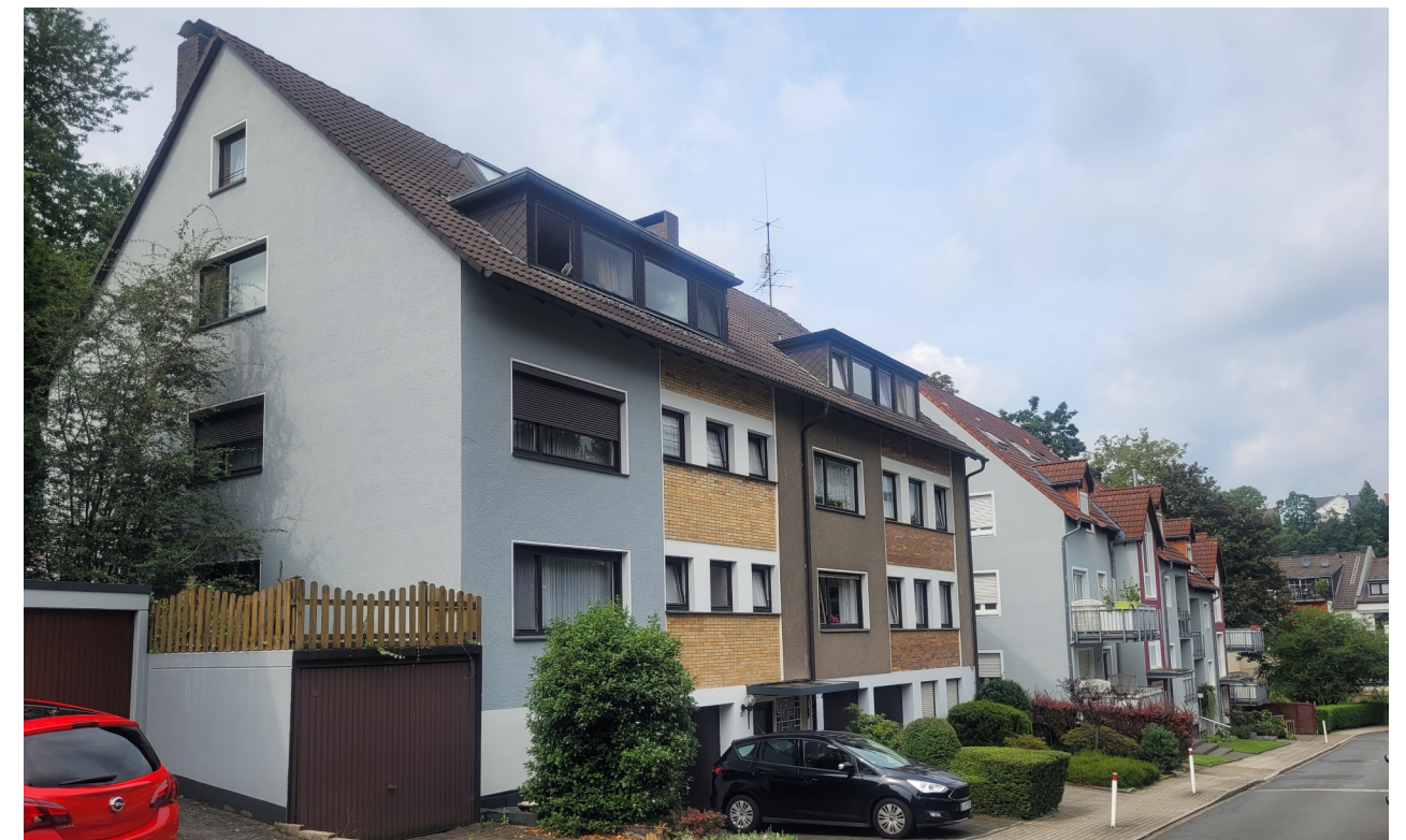
Wohnen im Stadtteil Werden; Foto: Stadt Essen, Amt für Stadterneuerung und Bodenmanagement
