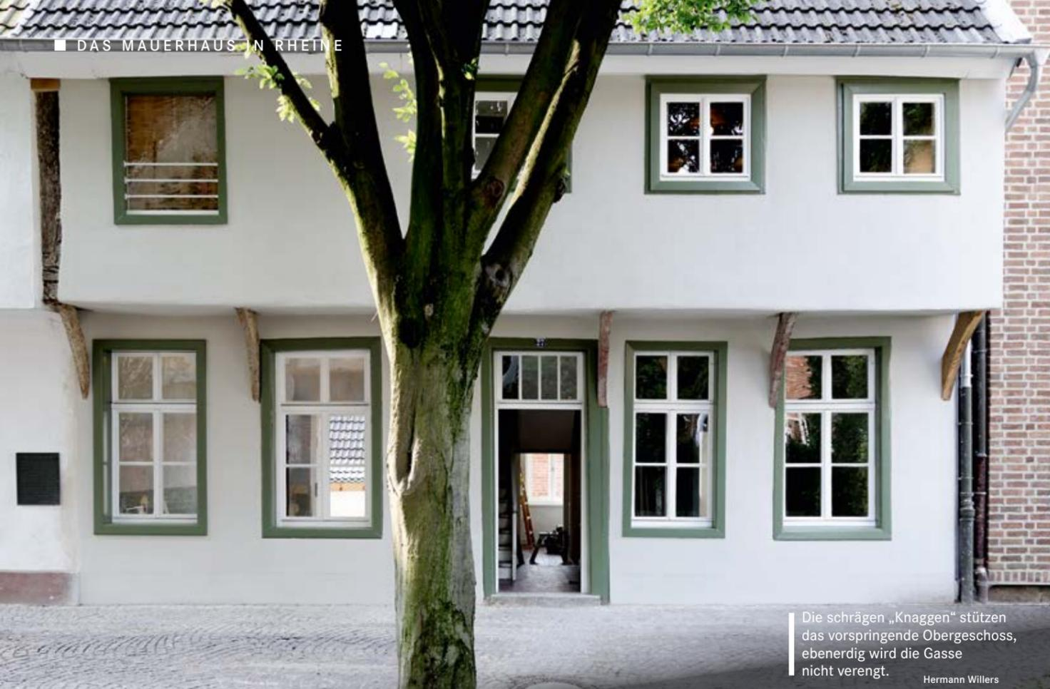
Die schrägen „Knaggen“ stützen das vorspringende Obergeschoss, ebenerdig wird die Gasse nicht verengt. Hermann Willers
