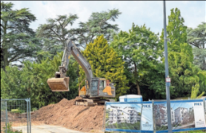
Die Bagger sind angerückt: An der Lindenstraße wird ein weiteres „Filetstück“ unter modernen Gesichtspunkten bebaut.
